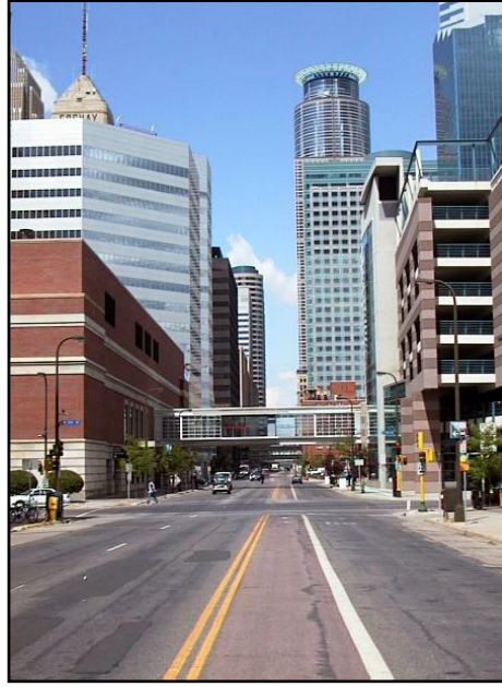
Gösterim 1. ABD -Minneapolis kentinden bir askı-geçit görünüşü (1)
