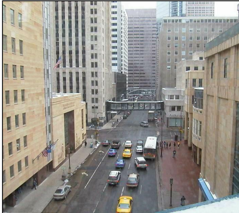
Gösterim 6. ABD -Minneapolis kentinden bir askı-geçit görünüşü (4)
