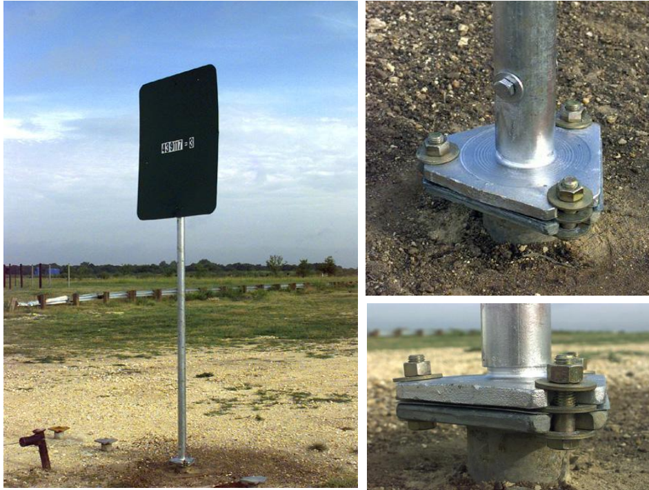
Şekil 1. Kırılabilir Direklere Ait Detaylar
