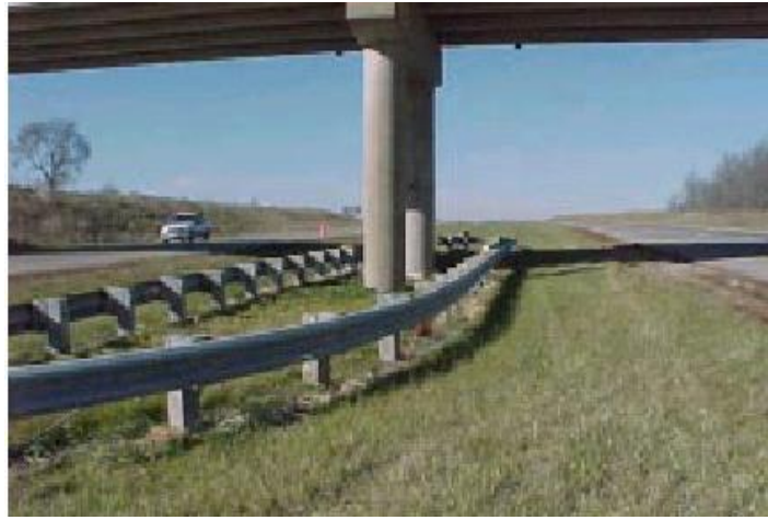
Şekil 4. Rijit Köprü Ayağına Çarpmayı Önleyen Bariyer Sistemi
