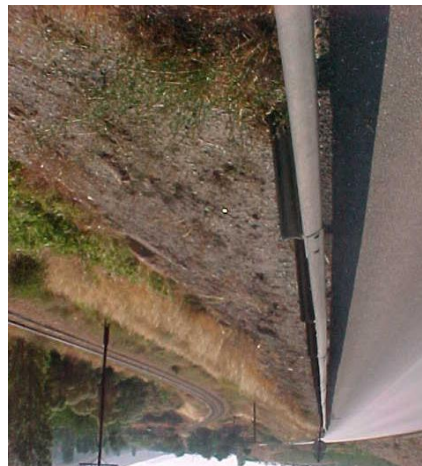
Şekil 5. Dik Şeve Yuvarlanmayı Önlemek İçin Kullanılan Bariyer Sistemi
