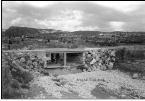
Fotoğraf 8. Mersin İli Avşar deresi kesitinin yol geçişi için daraltılması
